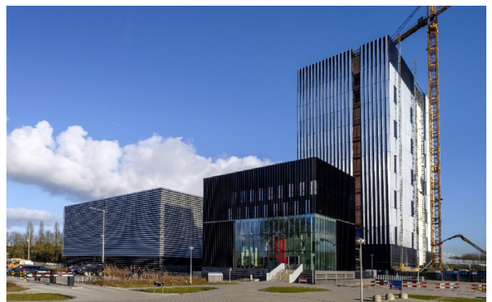
Fibrelite-sleufafdekkingen beschermen glasvezelkabels bij een toegangspunt voor hulpvoertuigen (afbeelding ter illustratie gebruikt, aangezien het daadwerkelijke datacenter niet kan worden getoond)
