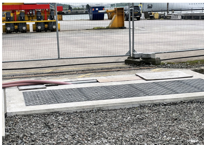
Fibrelite-afdekkingen zijn lichtgewicht en geschikt voor eenvoudige en veilige handmatige verwijdering
