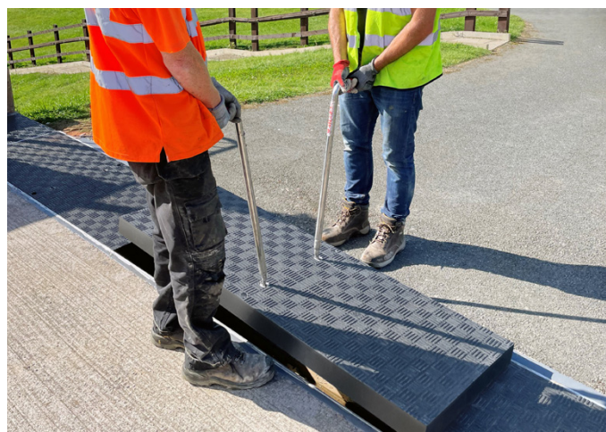
Gemakkelijke toegang tot de sleufvoorzieningen met behulp van de ergonomisch ontworpen FL7-hefhandels van Fibrelite (afbeelding dient ter illustratie en toont een andere installatie)
